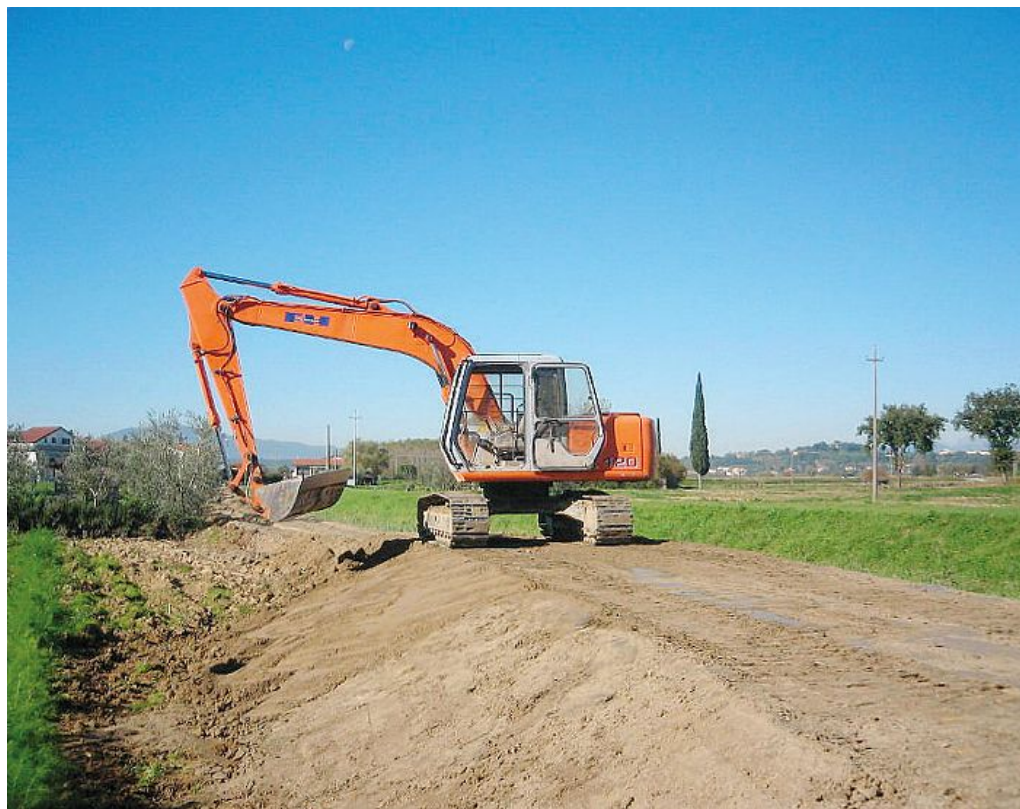
Lavori di manutenzione lungo un corso d'acqua
