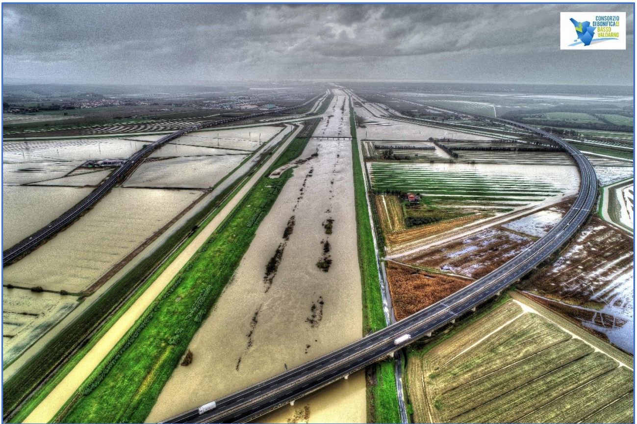
Fig. 10.19 - Il canale scolmatore in funzione nella piana di Guasticce durante l'alluvione del 18 novembre 2019 (foto di archivio del consorzio 4 Basso Valdarno)
