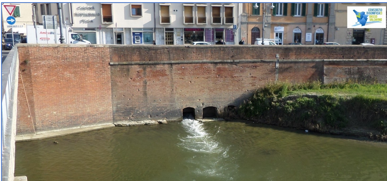
Fig.1.16 – Sbocco del Canale Demaniale di Ripafratta o fosso del Mulino presso il Ponte della Fortezza di Pisa (foto di archivio del consorzio 4 Basso Valdarno)
