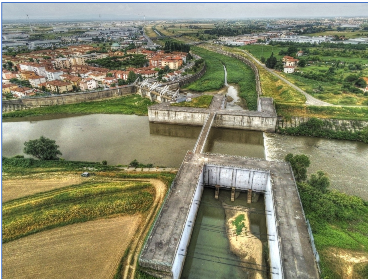
Fig. 6.3 – Le paratoie di presa dello scolmatore presso Pontedera (foto di archivio del consorzio 4 Basso Valdarno)
