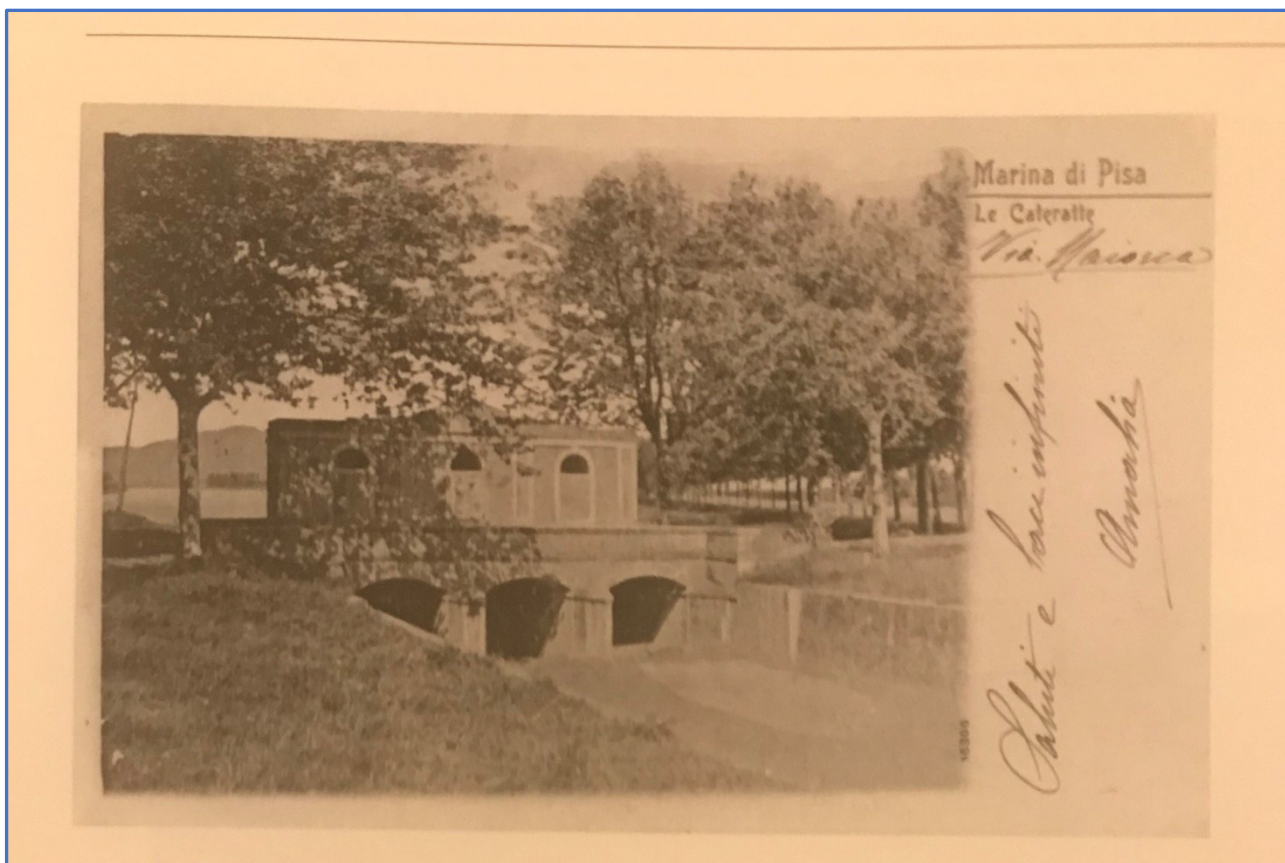
Fig. 10.36 - Opera idraulica delle cateratte delle “Le tre buche” realizzata nel 1606 – Marina di Pisa ( https://circoloilfortino.wordpress.com )
