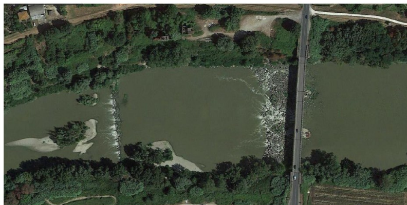
Fig. 2 - Vista aerea stato attuale
