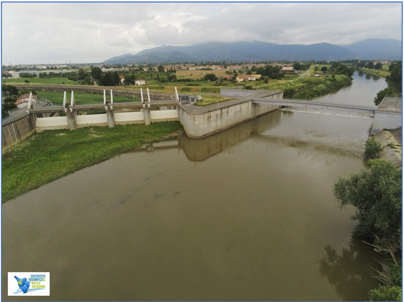
Fig. 10.18- Opera di presa del canale scolmatore vista da valle - Pontedera (foto di archivio del consorzio 4 Basso Valdarno)
