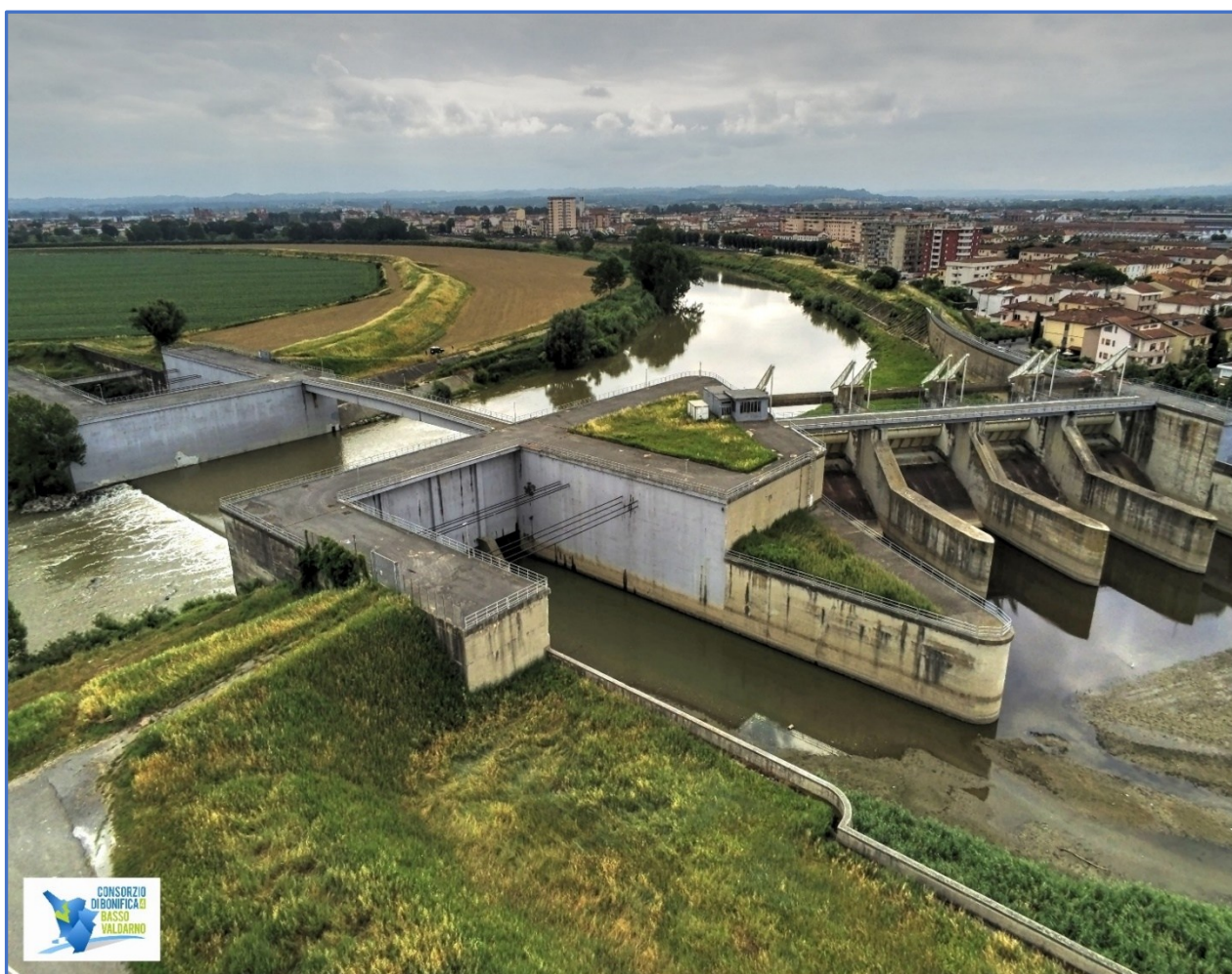
Fig. 10.17- Opera di presa del canale scolmatore vista da monte - Pontedera (foto di archivio del consorzio 4 Basso Valdarno)
